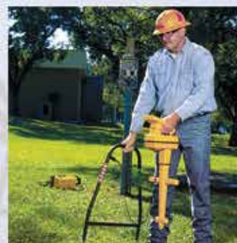
ΑΝΙΧΝΕΥΣΗ ΥΠΟΓΕΙΩΝ ΚΑΛΩΔΙΩΝ
